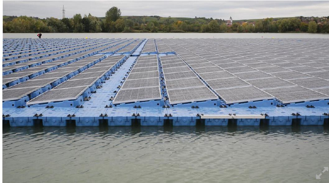
📷 4.000 schwimmende Module sind auf einem Dettelbacher Baggersee zu einem Solarkraftwerk verschraubt. Foto: Robert Haaf
