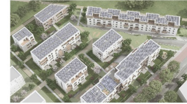
PV-Anlage zur gemeinsamen Energieerzeugung
